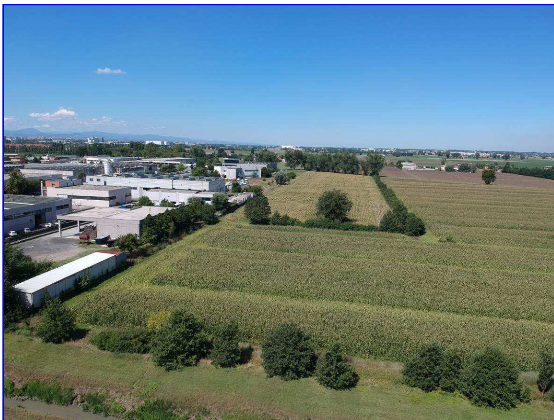
Figura 9 – Vista da est dell'area di intervento (in parte)
