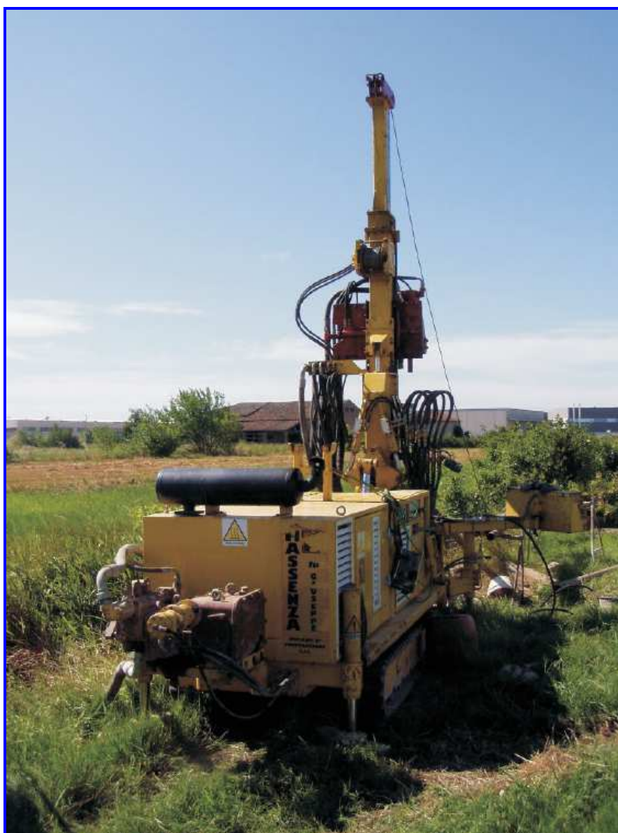
Fotografia 1 – Impianto cantiere per la realizzazione del sondaggio
